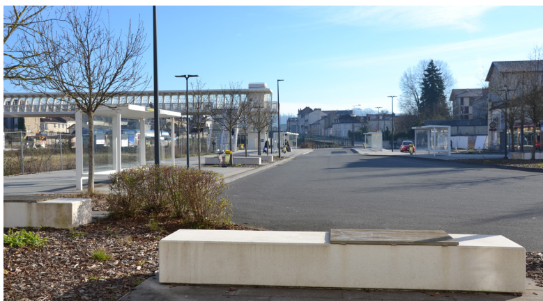
Pôle d'Échange Multimodal (PEM) et passerelle Simone Veil
