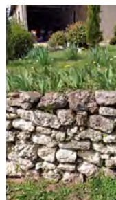
muret de pierres
