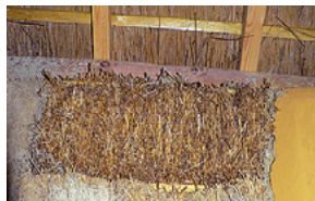
Une des étapes de finition d'un mur en paille
