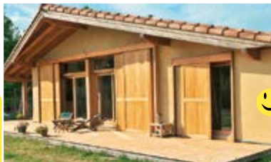
Volets coulissants et débord de toit au Sud
