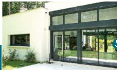
Séjour traversant, façade vitrée
