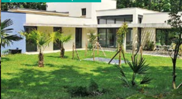
Façades Sud et Ouest avec pare-soleil
