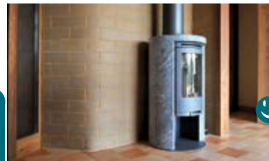
Poêle et mur en briques de terre crue
