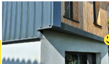
Bois, métal, maçonnerie enduite
